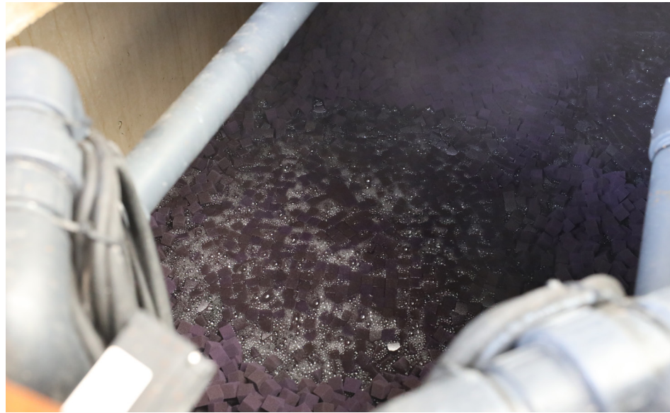
Das benötigte Wasser wird in einem Tank von Bakterien wiederaufbereitet.
