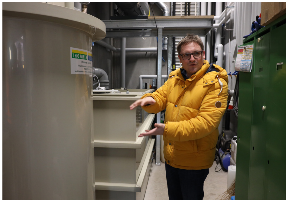
Geschäftsführer Lorenz Häuselmann erklärt die ökologische Waschanlage.
